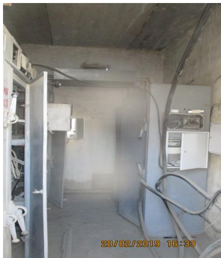
2.3. ТП-264/2 техникалық модернизациялау, мкр.Привокзальный. Өткізу қабілетін арттыратын 1х250кВА және 1х400кВА жабдықтарын 2х630кВА ауыстыру жоспарланған.
