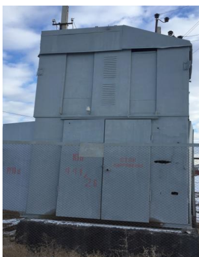
5.5. KTP-441/6 техникалық модернизациялау, Еркінқала. 250кВА жабдықтарын 250кВА ауыстыру, сымдарын СИП түріне ауыстыру.
