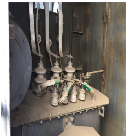
5.5. KTP-441/6 техникалық модернизациялау, Еркінқала. 250кВА жабдықтарын 250кВА ауыстыру, сымдарын СИП түріне ауыстыру.
