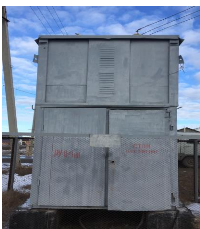
5.5. KTP-441/6 техникалық модернизациялау, Еркінқала. 250кВА жабдықтарын 250кВА ауыстыру, сымдарын СИП түріне ауыстыру.
