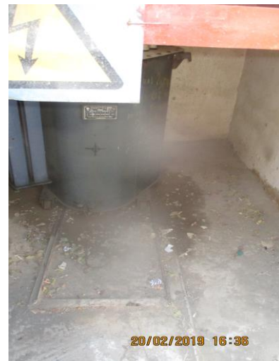
2.3. ТП-264/2 техникалық модернизациялау, мкр.Привокзальный. Өткізу қабілетін арттыратын 1х250кВА және 1х400кВА жабдықтарын 2х630кВА ауыстыру жоспарланған.
