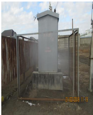
5.4. KTP-441/26 техникалық модернизациялау, Рақуша. Өткізу қабілетін арттыра отырып, 250кВА жабдықтарын 400кВА-ға ауыстыру, сымды СИП түріне ауыстыру жоспарлануда.
