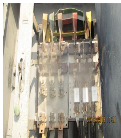
5.4. KTP-441/26 техникалық модернизациялау, Рақуша. Өткізу қабілетін арттыра отырып, 250кВА жабдықтарын 400кВА-ға ауыстыру, сымды СИП түріне ауыстыру жоспарлануда.
