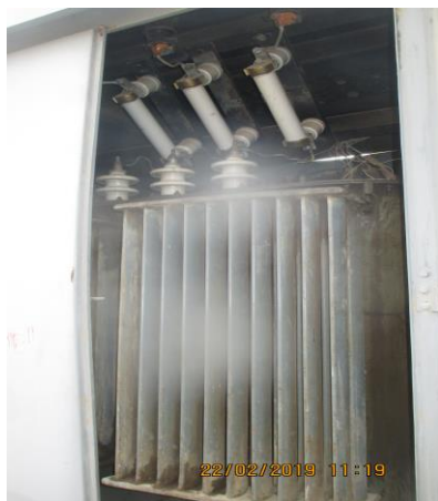
5.4. KTP-441/26 техникалық модернизациялау, Рақуша. Өткізу қабілетін арттыра отырып, 250кВА жабдықтарын 400кВА-ға ауыстыру, сымды СИП түріне ауыстыру жоспарлануда.
