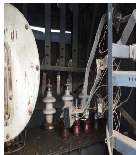
5.5. KTP-441/6 техникалық модернизациялау, Еркінқала. 250кВА жабдықтарын 250кВА ауыстыру, сымдарын СИП түріне ауыстыру.
