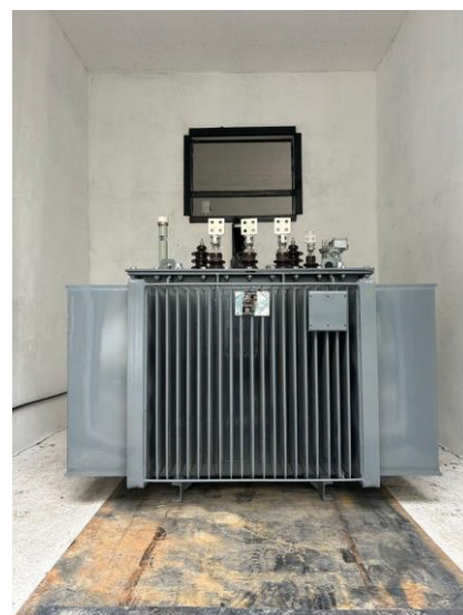
2.3. ТП-264/2 техникалық модернизациялау, мкр.Привокзальный. Өткізу қабілетін арттыратын 1х250кВА және 1х400кВА жабдықтарын 2х630кВА ауыстыру жоспарланған.
