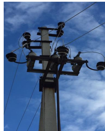
5.5. KTP-441/6 техникалық модернизациялау, Еркінқала. 250кВА жабдықтарын 250кВА ауыстыру, сымдарын СИП түріне ауыстыру.
